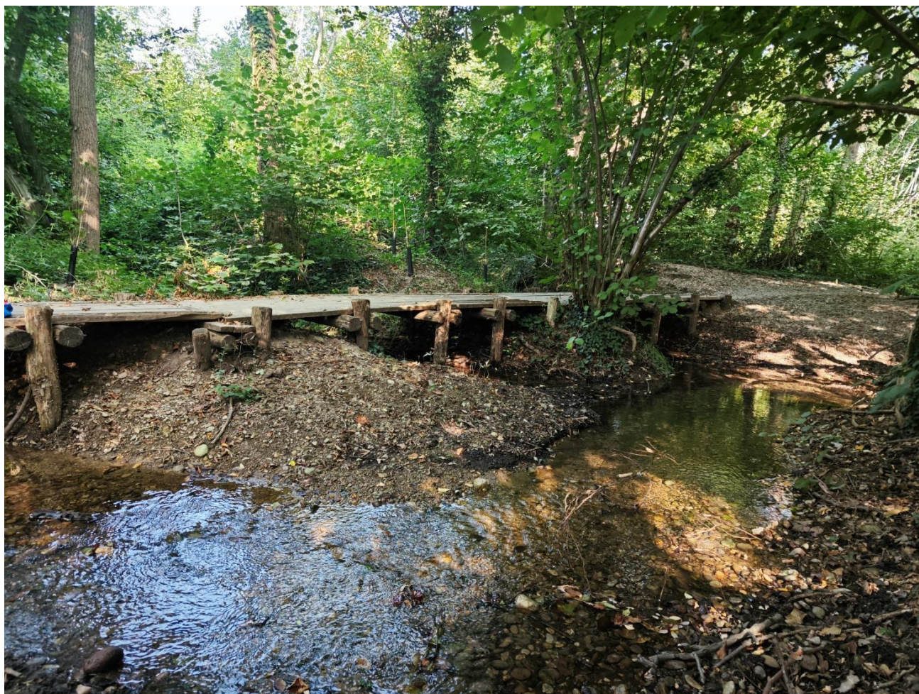
Passerelle sopra tre rami affluenti del corso principale.
