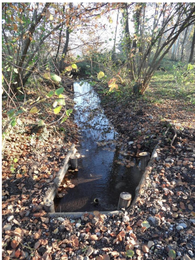
Esempi di fontanili da poco riqualificati. Si nota un utilizzo oculato delle palizzate in tratti limitati, solamente a difesa di piccoli capifonte che rischierebbero facilmente l'interramento a causa del materiale ghiaioso delle sponde e dei depositi in corrispondenza dei pochi tubi Norton.
