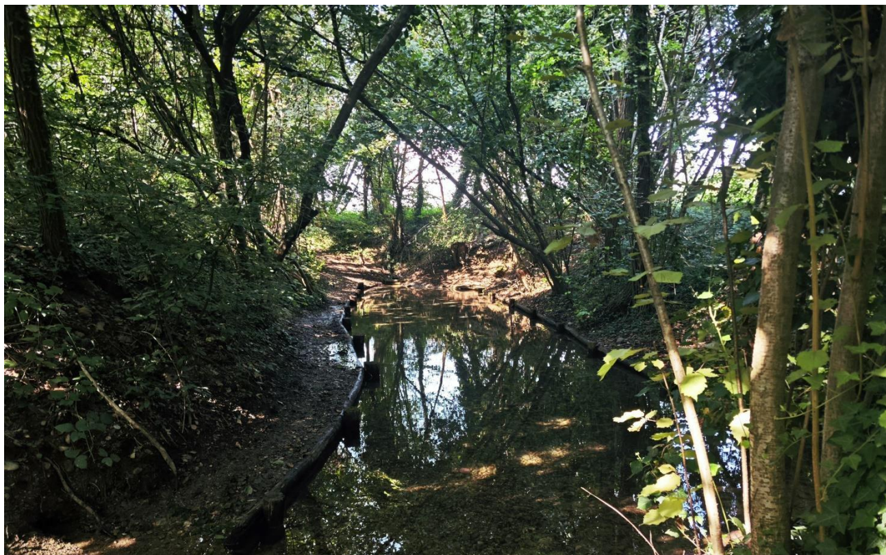
Un capofonte con basse palizzate di contenimento delle rive. Il fondale pressoché piatto di questi fontanili e i pochi centimetri di acqua traggono vantaggio da un leggero e mirato contenimento delle sponde più scoscese, per evitare piccole frane con conseguente occlusione delle emergenze, le quali sono tutte naturali.
