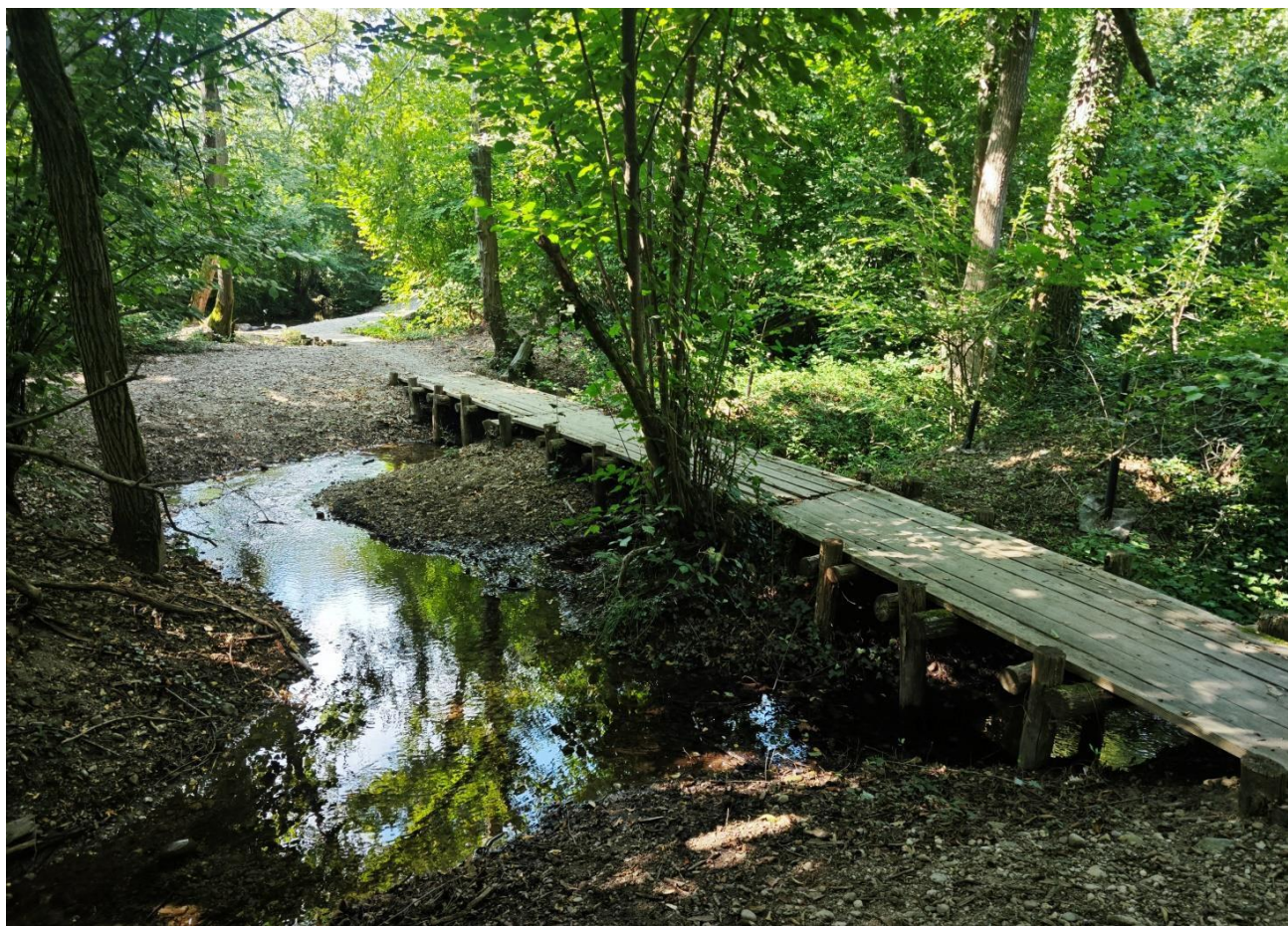
Passerelle sopra tre rami affluenti.
